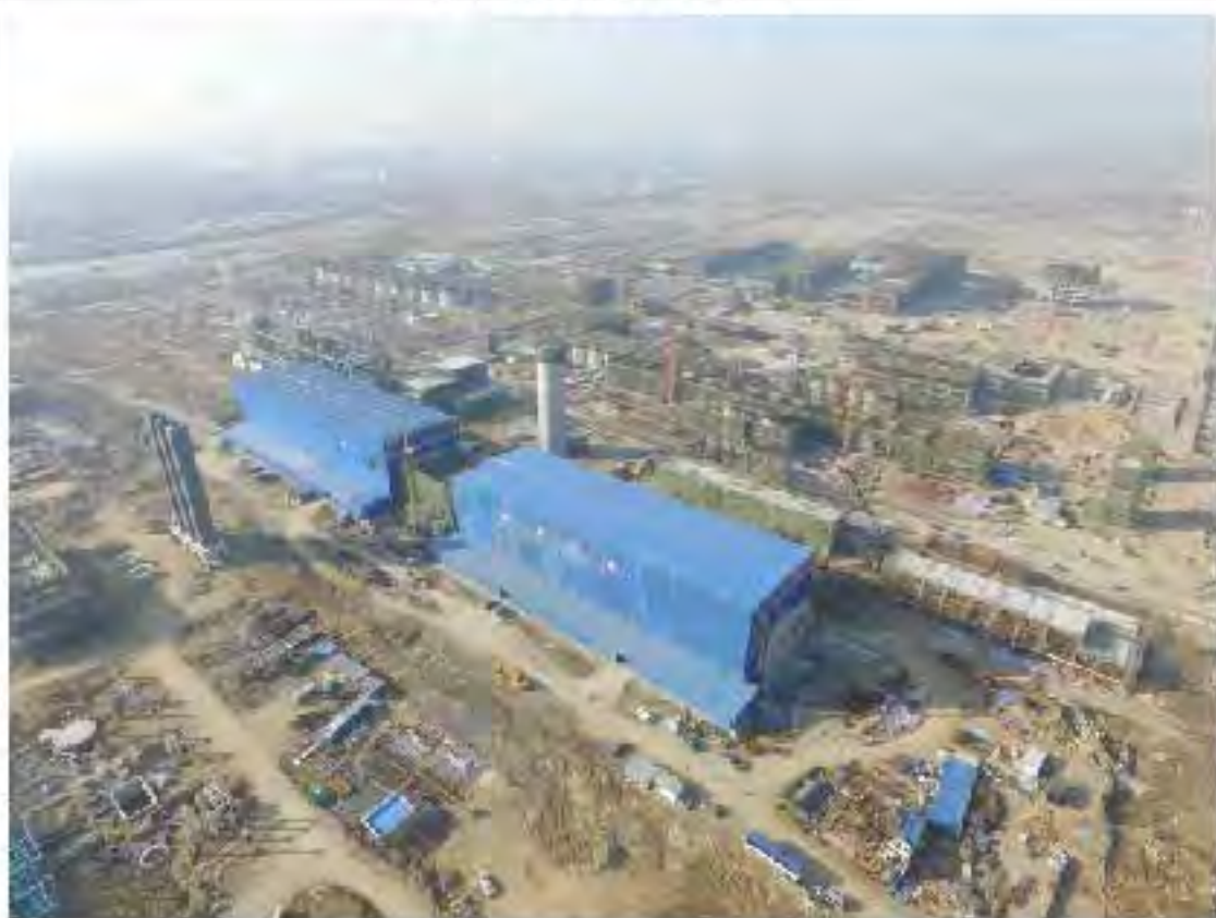
厂房内航拍影像 (2017.01)
