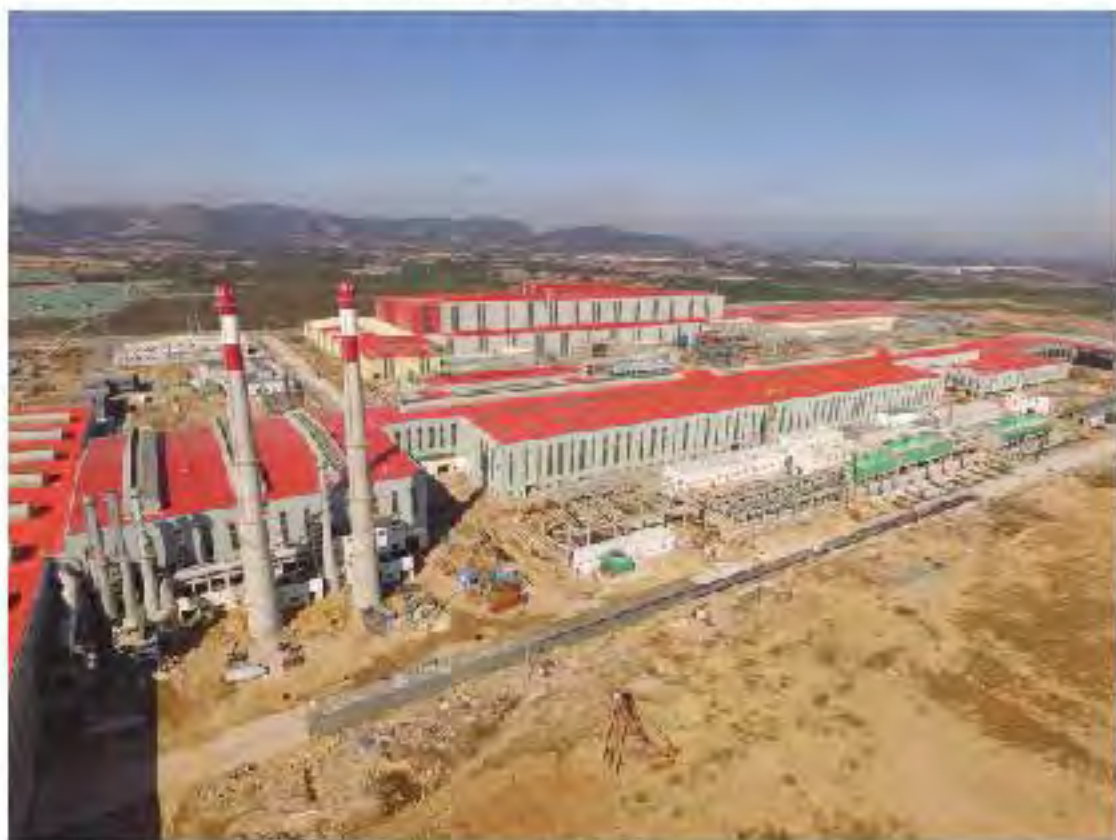
厂区内施工航拍影像 (2017.10)
