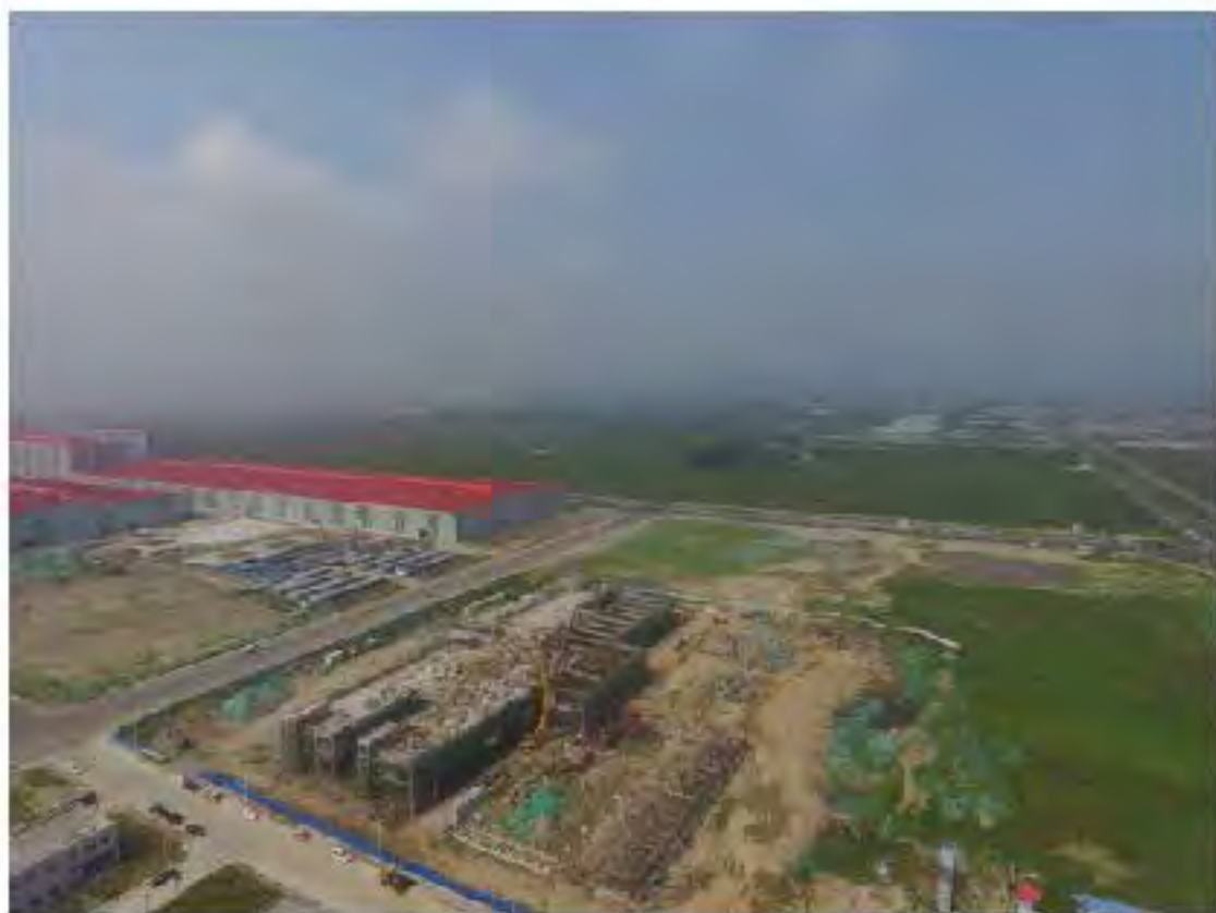
厂区内施工航拍影像（2018.08）
