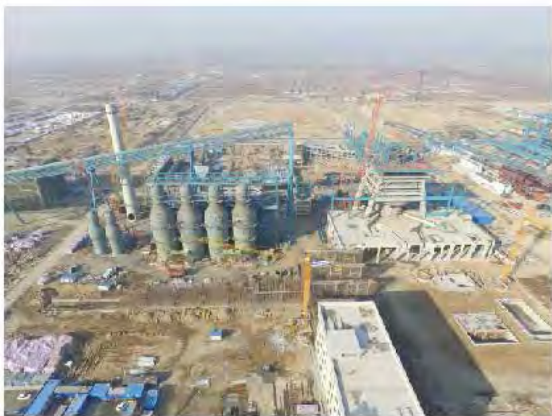
高炉区航拍影像 (2017.01)
